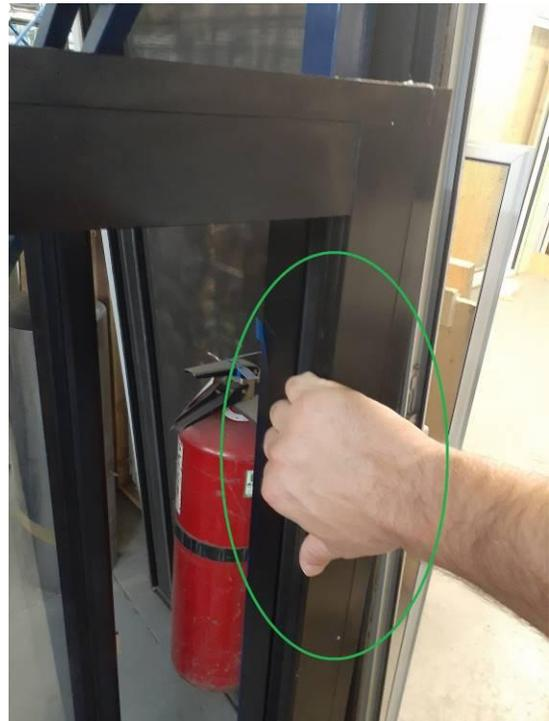
2. Fixer la fenêtre à la charpente de la maison, dans les trous pré-perçés en usine, avec des vis #10, tête ronde (enduit zinc; plaqué nickel-chrome; acier inoxydable ou aluminium), longueur minimale de 3 po. (Utilisez les calles d'installation adéquatement, l'installation d'une fenêtre doit être faite par un professionnel).
