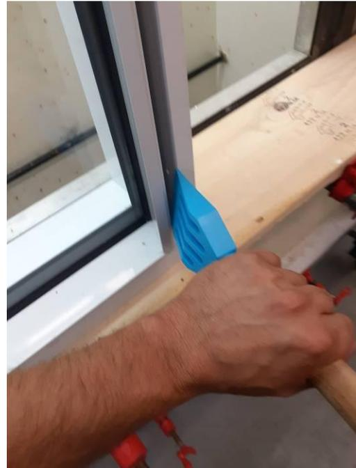
2. Sécuriser temporairement le positionnement préliminaire de la fenêtre dans son ouverture en vissant au moins 2 vis #10, tête ronde, d'une longueur minimale de 3'' (enduit zinc; plaqué nickel-chrome; acier inoxydable ou aluminium), dans la tête de la fenêtre ou le haut du jambage de la fenêtre (Le temps d'ajuster le niveau et l'équerrage de la fenêtre).
