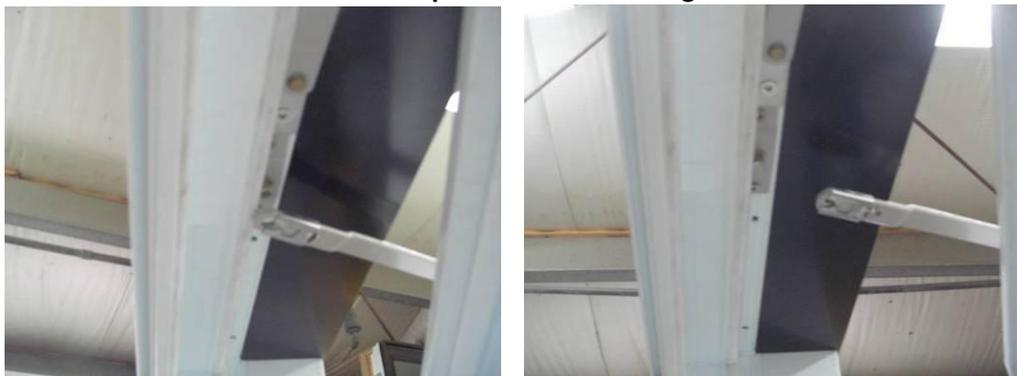
**Pour activer le mécanisme à nouveau, il suffit de remettre le loquet en place, à l'aide d'un tournevis « plat ».**
