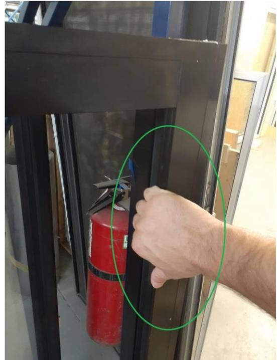
3. Fixer la fenêtre à la charpente de la maison, dans les trous pré-perçés en usine, avec des vis #10, **tête ronde** (enduit zinc; plaqué nickel-chrome; acier inoxydable ou aluminium). Une vis d'une longueur minimale de 3" ou plus est requise selon l'espace entre le fond de clouage et la fenêtre (Utilisez les calles d'installation adéquatement, l'installation d'une fenêtre doit être faite par un professionnel).
