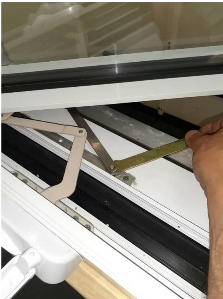
Une fois le volet centré, le dégagement entre le périmètre du volet et le cadre doit être entre 1.5mm et 5.5mm (**nom. = 3.5mm - 1/8po.**)
