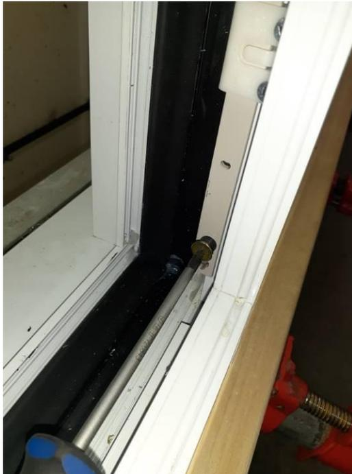
Une fois le volet positionné, le dégagement entre le volet et le cadre doit être entre 0.5mm et 2.5mm (**nom. = 1.5mm - 1/16po.**)
