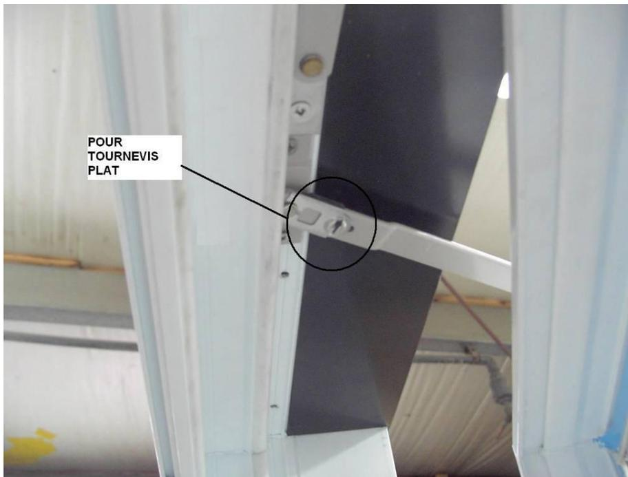
**Avec un tournevis « Plat », désactiver la barrure du mécanisme en faisant glisser le loquet métallique vers l'extérieur.**
