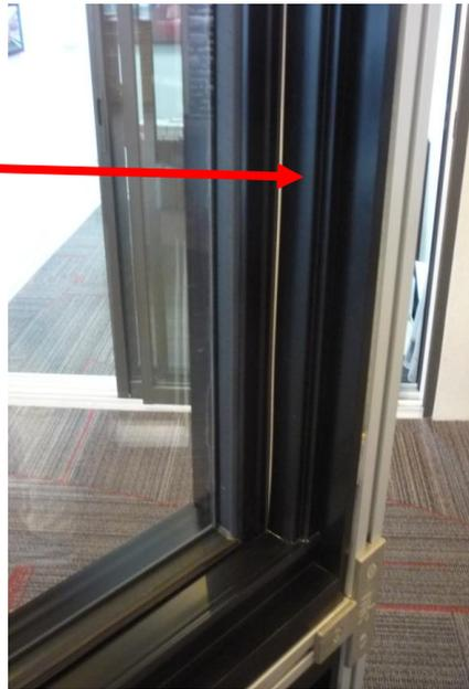
2. Pour installer le volet opérant, si nécessaire, faites pivoter la poignée environ 5 tours complets. Aligner le patin du haut et celui du bas dans leurs rails. Glisser ensuite le volet dans ses rails et pousser les deux barres dans leur pivot.
