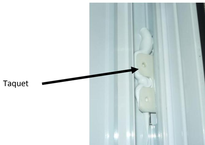
f) Sceller les taquets. Tirer un joint de scellant entre le volet et la boîte dans le bas et le haut du volet.
