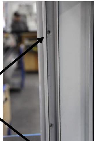
2. Ajuster la hauteur des roulettes du volet extérieur afin que ce dernier soit parallèle à la tête du cadre. Utiliser un tournevis étoile; visser pour faire monter le volet dévisser pour le faire descendre
