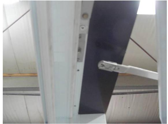
**Pour activer le mécanisme à nouveau, il suffit de remettre le loquet en place, à l'aide d'un tournevis « plat ».**
