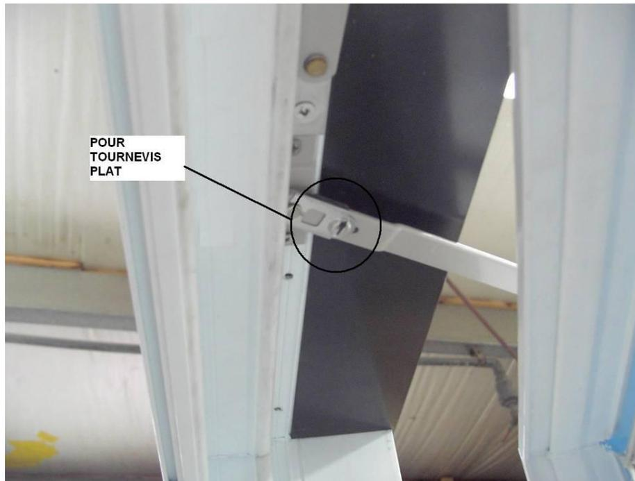
**Avec un tournevis « Plat », désactiver la barrure du mécanisme en faisant glisser le loquet métallique vers l'extérieur.**
