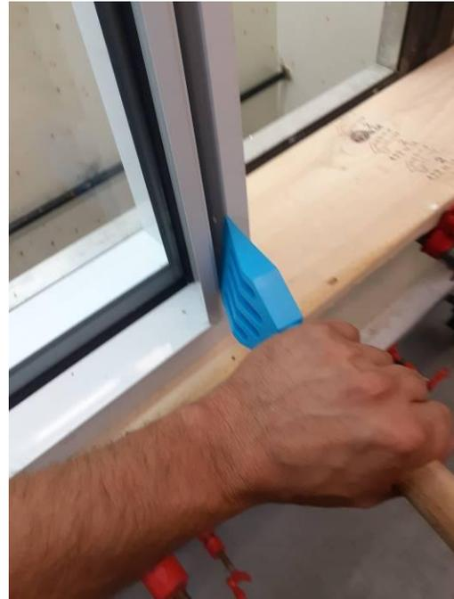
2. Sécuriser temporairement le positionnement préliminaire de la fenêtre dans son ouverture en vissant au moins 2 vis #10, tête ronde, d'une longueur minimale de 3'' (enduit zinc; plaqué nickel-chrome; acier inoxydable ou aluminium), dans la tête de la fenêtre ou le haut du jambage de la fenêtre (Le temps d'ajuster le niveau et l'équerrage de la fenêtre).
