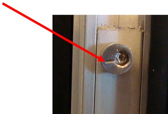
d) Ajustement compression côté penture : option limiteur de déflexion
